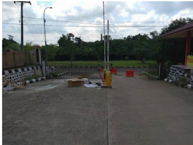
Pemasangan Sistem **palang parkir Otomatis** sistem **Kartu** , atau kami sebut sistem parkir RFID
