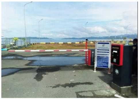
Sistem palang parkir otomatis yang dipasang di Pelabuhan Bacan menggunakan sensor pendeteksi kendaraan untuk membuka dan menutup palang secara otomatis. Sistem ini juga dilengkapi dengan sistem akses kontrol yang menggunakan kartu RFID untuk mengontrol akses kendaraan masuk dan keluar dari area parkir.
