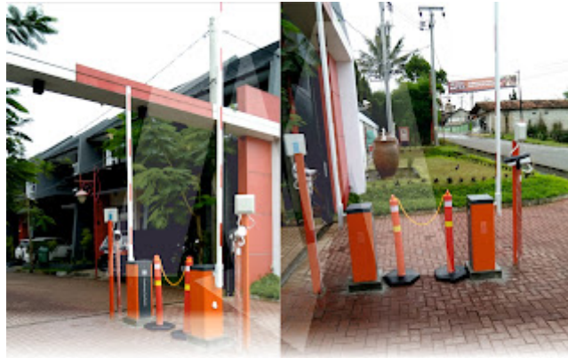
SYSTEM GATE : LONGRANGE RFID SYSTEM LOKASI PEMASANGAN : PERUMAHAN SSP CIMAH
