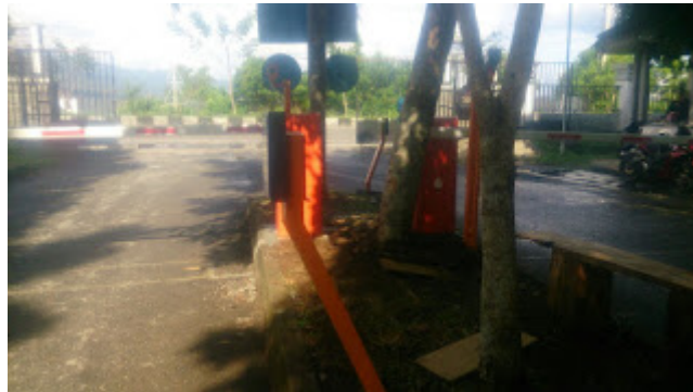
Universitas Pattimura Ambon Pemasangan palang parkir dengan sistem kartu atau di sebut RFID
