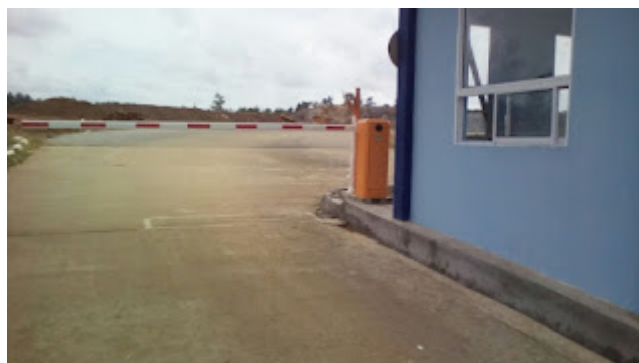
Gbr Pintu Keluar Pelabuhan Roro
