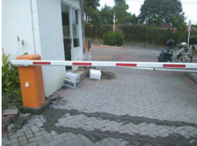
**Pemasangan Sistem parkir atau portal otomatis untuk perumahan sistem yang di gunakan adalah sistem kartu RFID OFFLINE**
