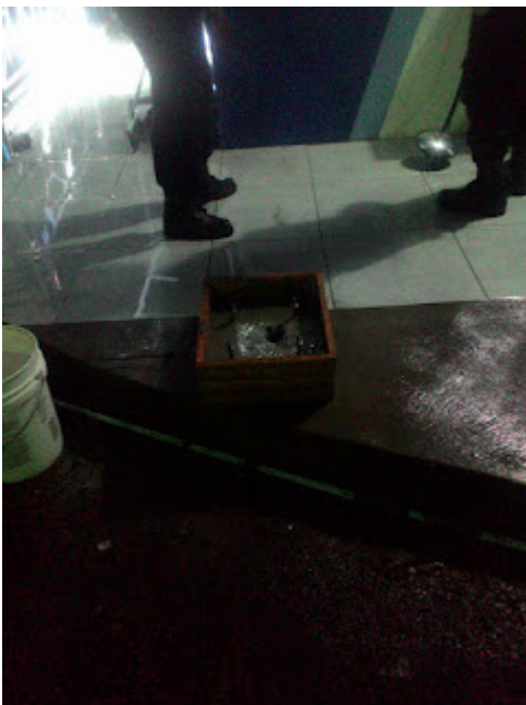
Pada saat membuat pondasi bagi dudukan barrier gate dan
