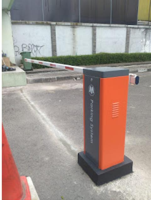
Pemasangan Sistem parkir terbaru di Bandung tepatnya di BIOFARMA Bandung yaitu pemasangan **barrier gate system** dengan **pola tapping kartu** atau yang di kenal dengan system RFID Online pada gedung Basement area Parkir B di Kantor Biofarma Tersebut sistem ini dilengkapi dengan System **LOT parkir tau PGS (parking Guide System)**
