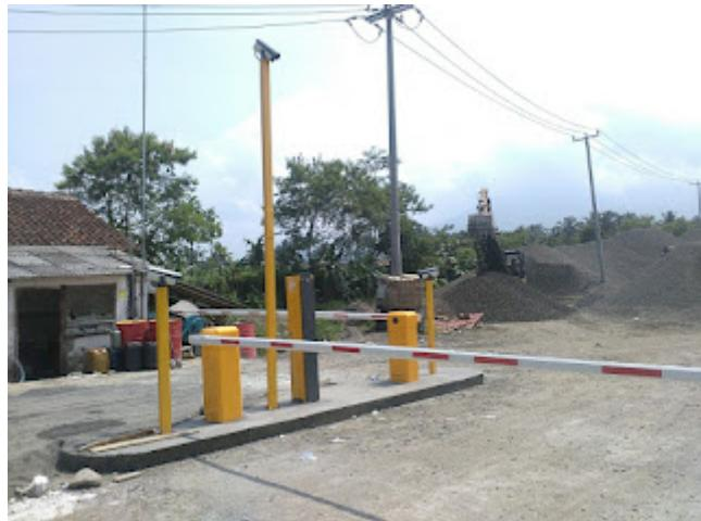
pemasangan portal otomatis untuk system pertambangan bertujuan untuk menanggulangi tingkat kebocoran. sistem ini mencatat jumlah keluar masuknya kendaraan proyek / truck dalam melakukan pembelian pasir/batu dsb
