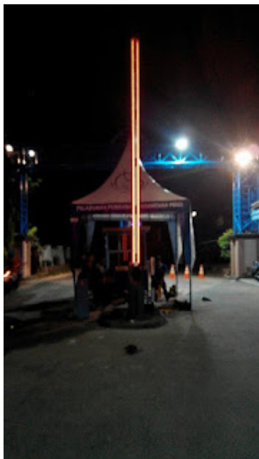
Pemasangan Sistem Parkir di PPN Prigi
