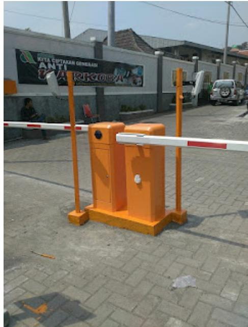
Pemasangan Sistem Parkir Long Range RFID Dimana Alat ini berfungsi mendeteksi kendaraan dari jarak 6-12 Meter (bisa disesuaikan) yang memiliki Card RFID terdaftar dan memerintahkan membuka portal elektrik/ barrier gate secara otomatis Pemasangan sistem parkir ini di salah satu RSUD kota Semarang
