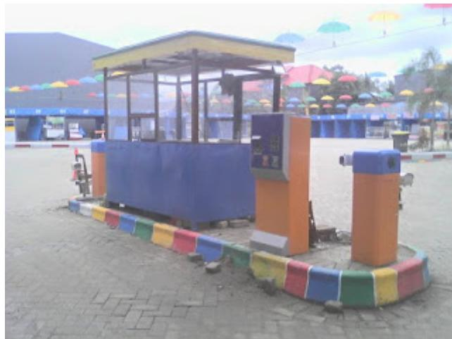
*Ini merupakan Paket sistem parkir ekonomis 1 Gate In dan 1 Gate Out dengan harga yang terjangkau, sistem parkir ini teruji layak dipakai di area frekuensi tinggi dan aktifitas 24 jam Non stop karena didesign khusus untuk out door / tanpa menggunakan PC dalam Box dispenser atau tiket dispenser. didukung IP Camera sebagai alat keamanan (data) sistem Card Reader Untuk Karyawan atau member dan produk kami ini sangat disaran kan bagi yang ingin*
